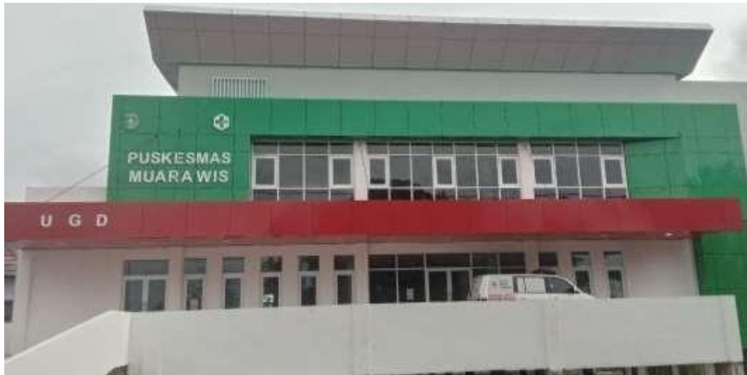
Foto 13: Pembangunan Fisik Puskesmas Muara Wis
