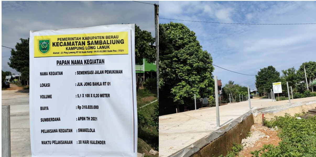
Keterangan: Contoh Pembangunan yakni semenisasi jalan pemukiman kampung Long Lanuk, Diakses pada 15 Februari 2025 Sumber : Website Kampung Long-Lanuk, 2024
