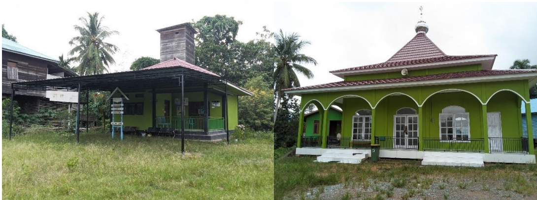
Keterangan: Pembangunan Masjid di masa kepemimpinan Pak Solaiman, S.sos Sumber : Dokumentasi pribadi, 2024
